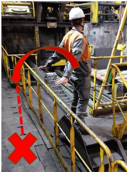
**Le garde-corps doit empêcher toute chute que ce soit à travers, au-dessous ou au-dessus. (il doit aussi empêcher l'accès à une zone dangereuse)**
