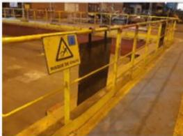
**Le garde-corps doit être fixé, solide, continu, en état et non démontable sans outil**
